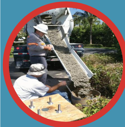
Workers pour cement for light poles.
